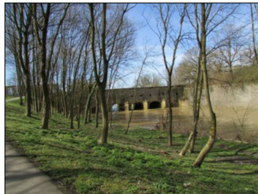
Pont sur le canal des Ecluses
