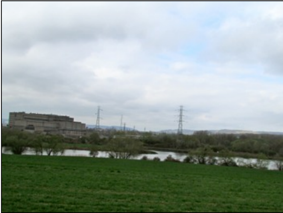
la centrale en déconstruction
